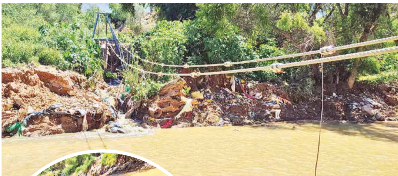
El punto de ingreso de las aguas servidas de Pucara al río.
