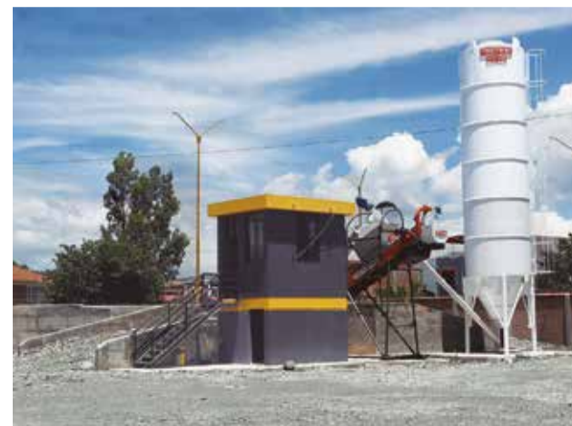
Los equipos de la planta de hormigón en Quillacollo.
