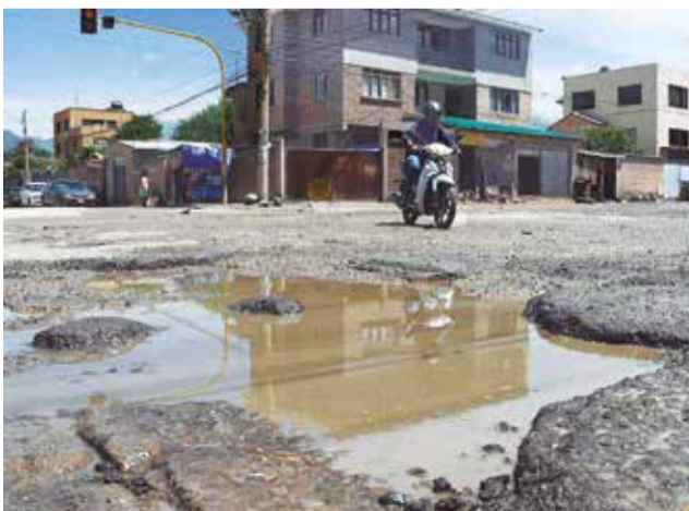
El mal estado de la avenida Capitán Arzabe.
