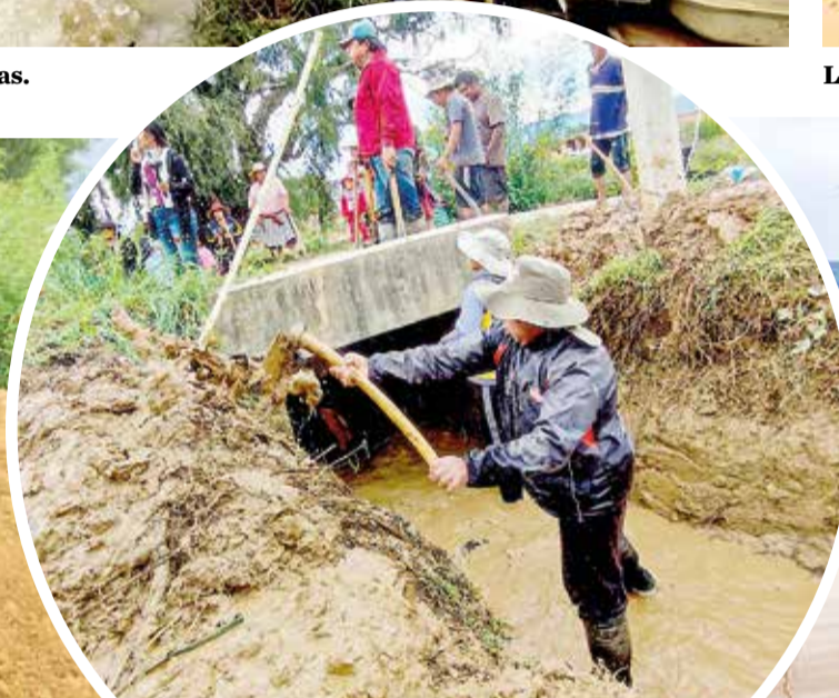
Limpieza de una acequia para evitar que rebalse.
