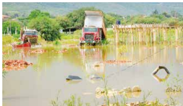
Una fábrica de materiales inundada en Tolata.
