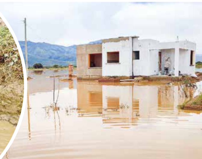
Las casas anegadas en Barrios Unidos.
