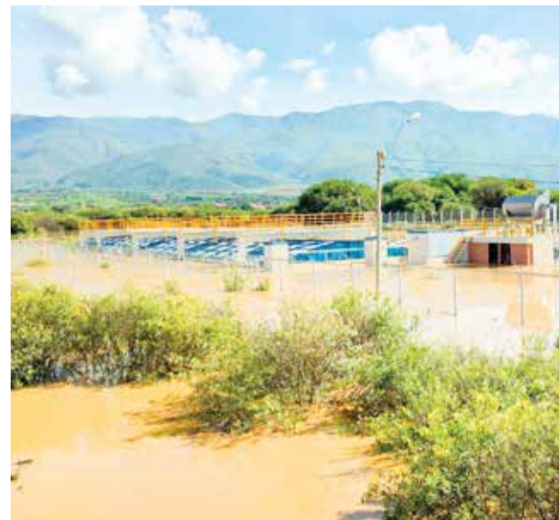
La planta de aguas servidas inundada.
