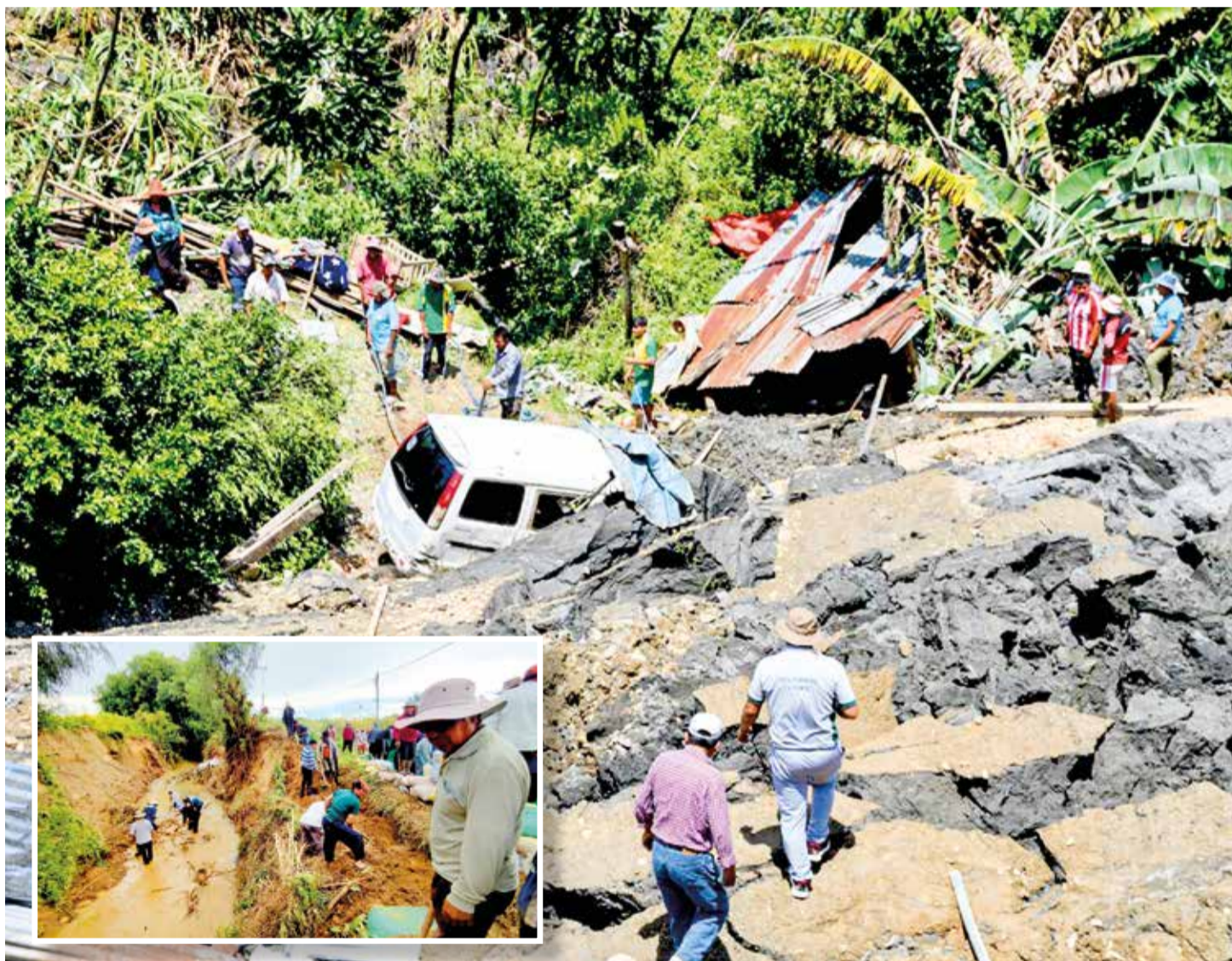
Foto grande: inspección tras el derrumbe en La Asunta. Foto chica: trabajos en Cliza ante el rebalse en "aguas negras". HOY NOTICIAS - D. JAMES
