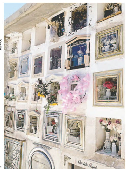
Faltan espacios en pabellones del Cementerio / LA PATRIA
