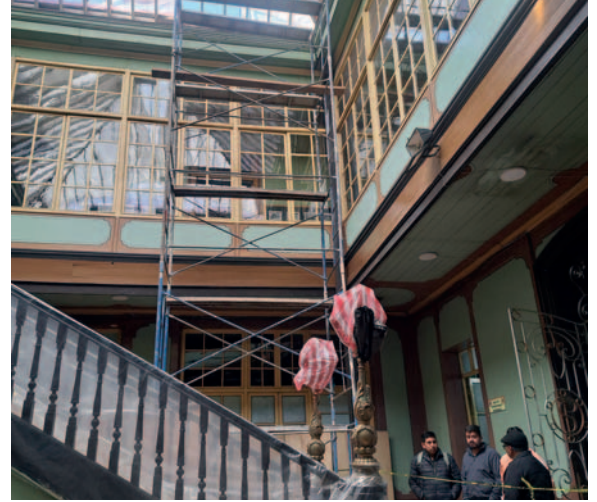
Trabajos comenzaron a finales de 2023 /UTO
