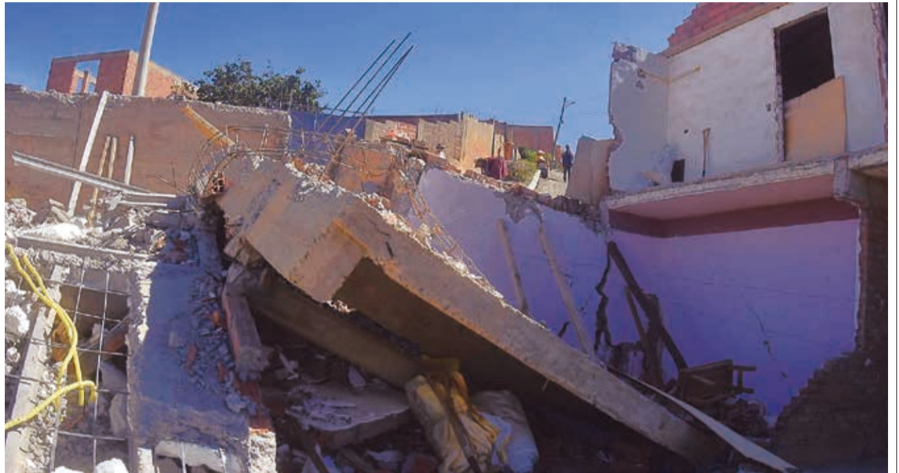
Los trabajos de ampliación en la avenida Costanera del Sur, hacia la nueva terminal. JOSÉ ROCHA
