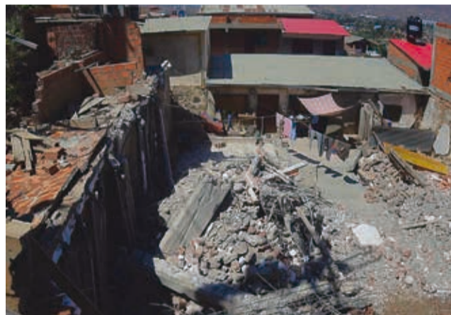
Maquinaria realiza el movimiento de tierras. JOSÉ ROCHA
