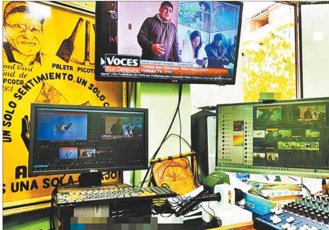
INSTALACIONES. Los equipos de la emisora FM Bolivia que utilizan para sus transmisiones.
