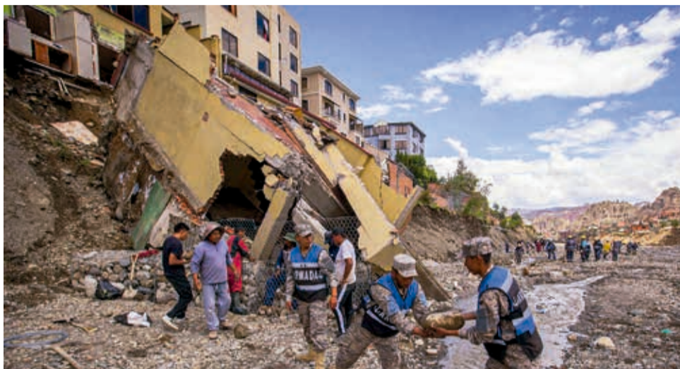
Las viviendas afectadas por las inundaciones en la zona de Irpavi, de La Paz. APG
