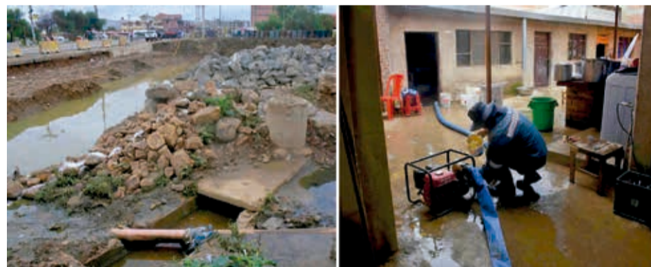
Calles y casas afectadas por el río de La Tamborada, en el sur. HERNÁN ANDÍA
