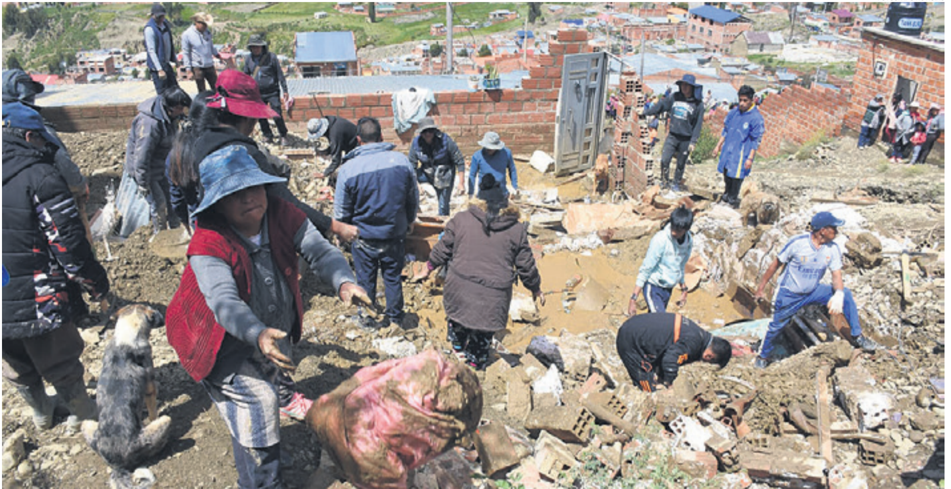
PRODUCTO DE LAS LLUVIAS. Una mujer y sus dos hijos perdieron la vida al interior de su vivienda que quedó sepultada. La desgracia ocurrió en la urbanización Arco Iris
