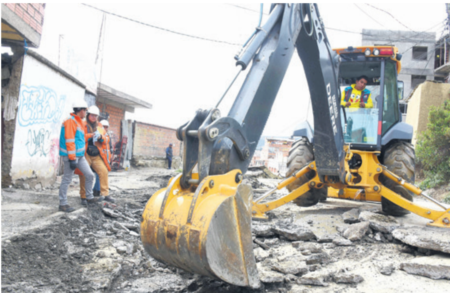
El Gobierno Municipal desplazó maquinaria y retiró más de 240 metros cúbicos de material de arrastre en más de 40 sectores
