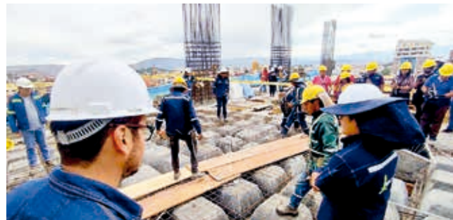
La inspección técnica al edificio. AFP
