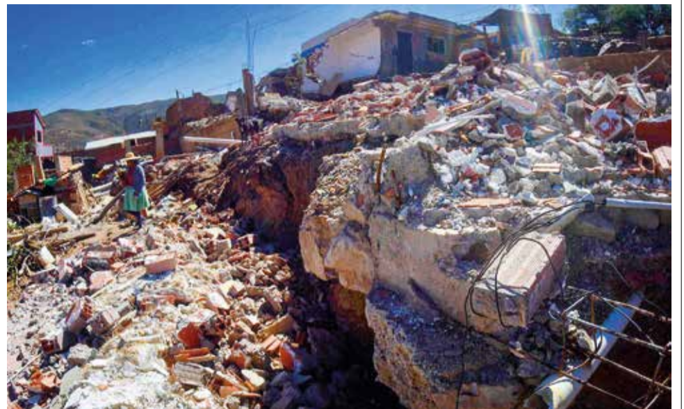
Las viviendas que colapsaron en la OTB Libertad por los deslizamientos. JOSÉ ROCHA
