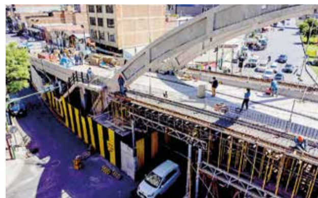
Obras para reponer la plataforma del puente caído. GAMC
