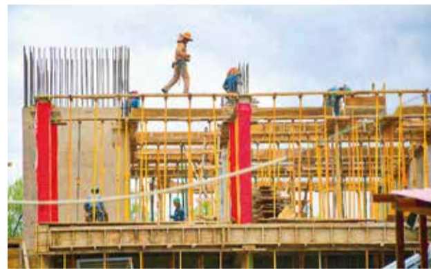
Las obras del centro de radioterapia en el hípico. C. LÓPEZ
