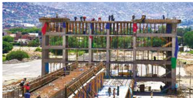
La nueva terminal de Albarrancho, donde llegará la línea del tren. CARLOS LÓPEZ
