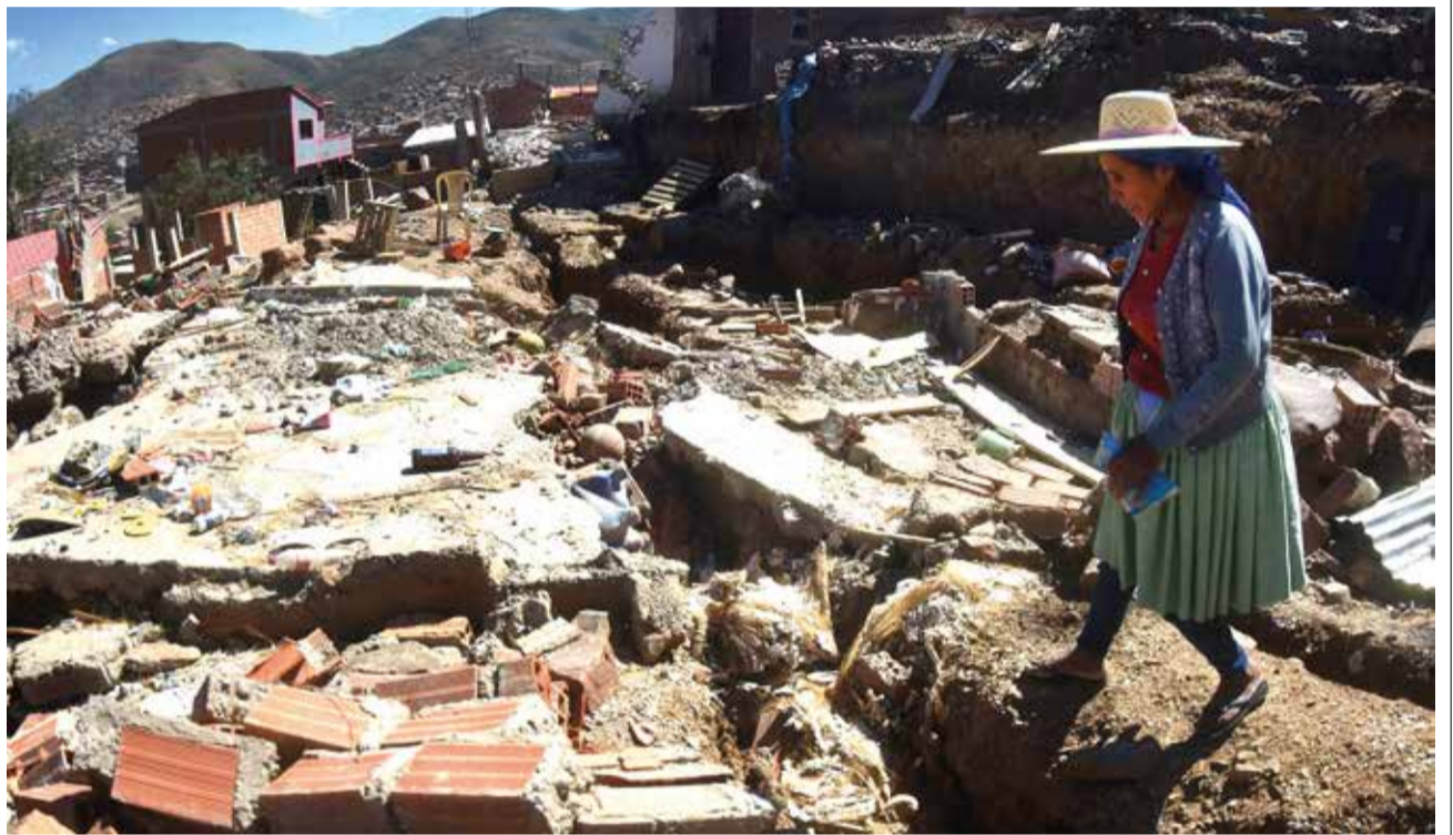
Las viviendas deterioradas por los deslizamientos en Takoloma, en la zona sur de la ciudad. FOTOS: JOSÉ ROCHA
