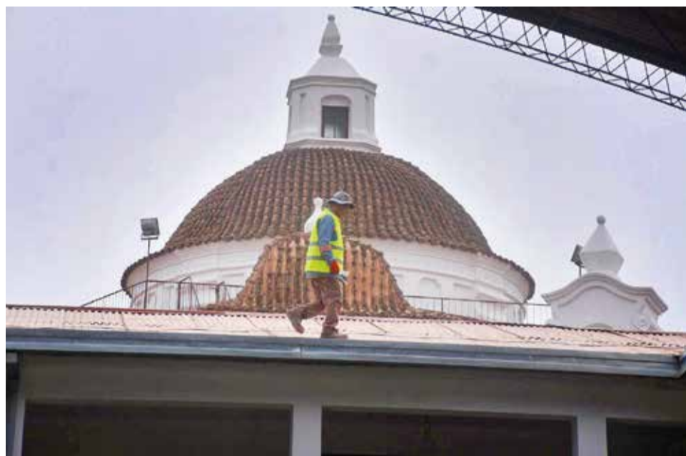
Personal de Obras Públicas limpia las canaletas en la escuela Cobija. FOTOS: JOSÉ ROCHA
