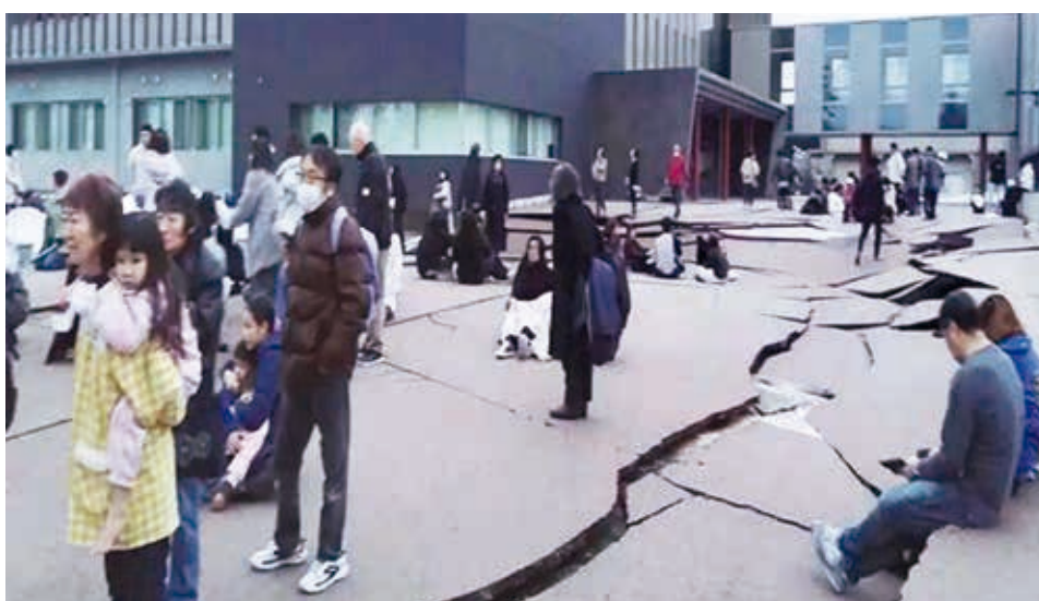
Roturas en las calles de Japón por efecto del sismo de 7,6 en la escala Richter.
