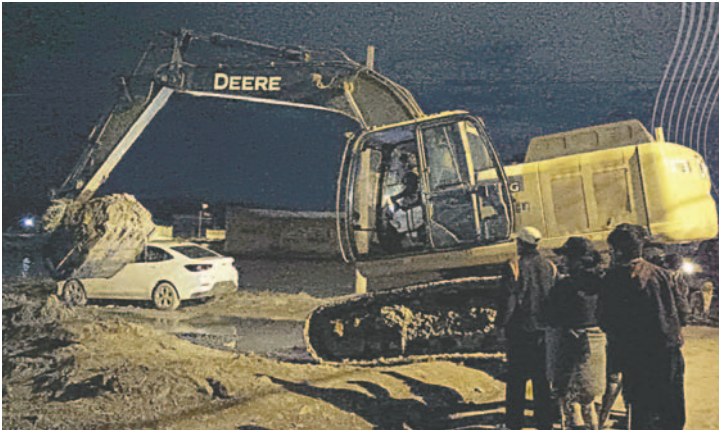
Continúan los trabajos para abrir zanjas y evacuar aguas /GAMO
