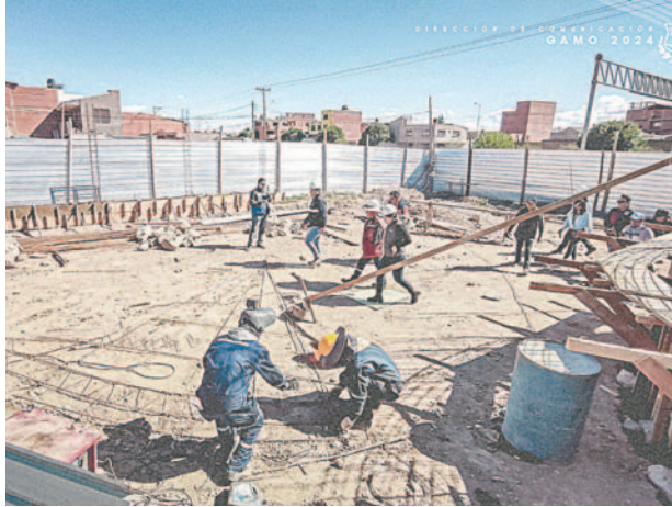
Avanza construcción de la estación elevadora / GAMO
