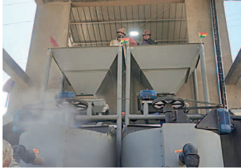
Entrega de Planta de Pre-Tratamiento para aguas ácidas de la Mina San José / LA PATRIA
