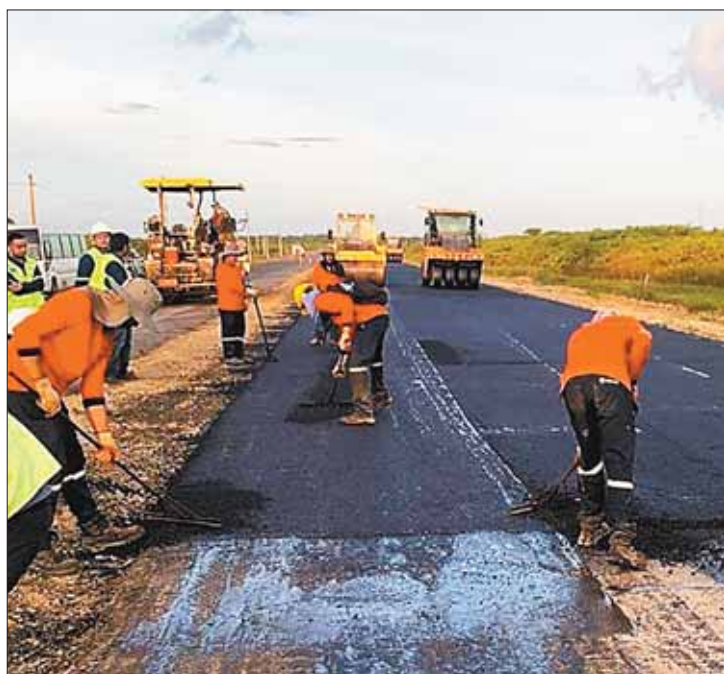
TRABAJOS. Los recursos se destinan a construcción de carreteras.
