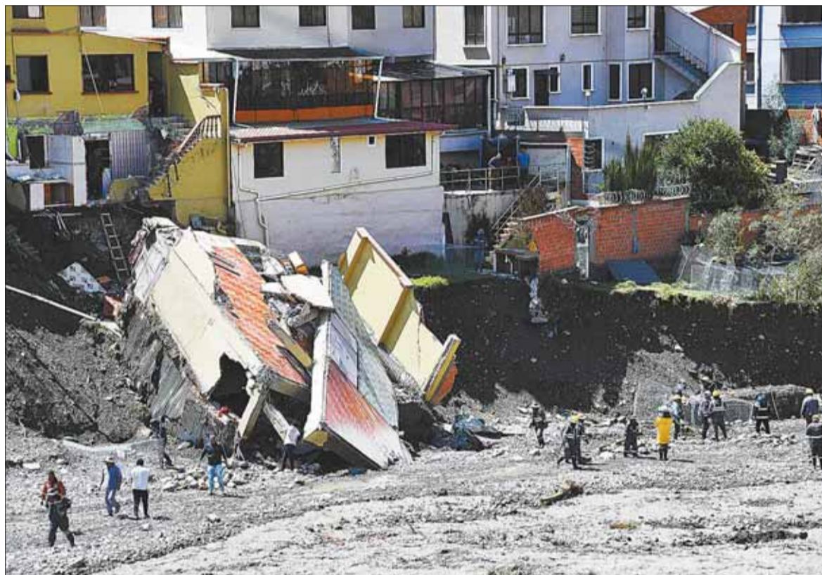
PREOCUPACIÓN. La vivienda colapsó durante la madrugada, debido a las lluvias y el ascenso del río.
