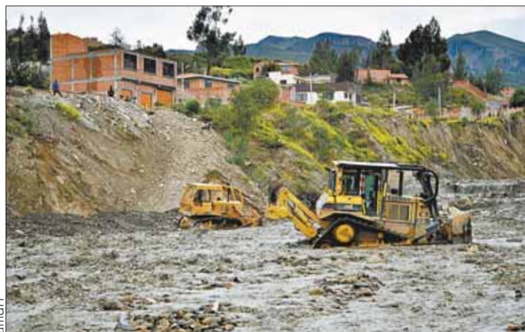
EMERGENCIA. Maquinaria de la Alcaldía trabaja en los ríos.
