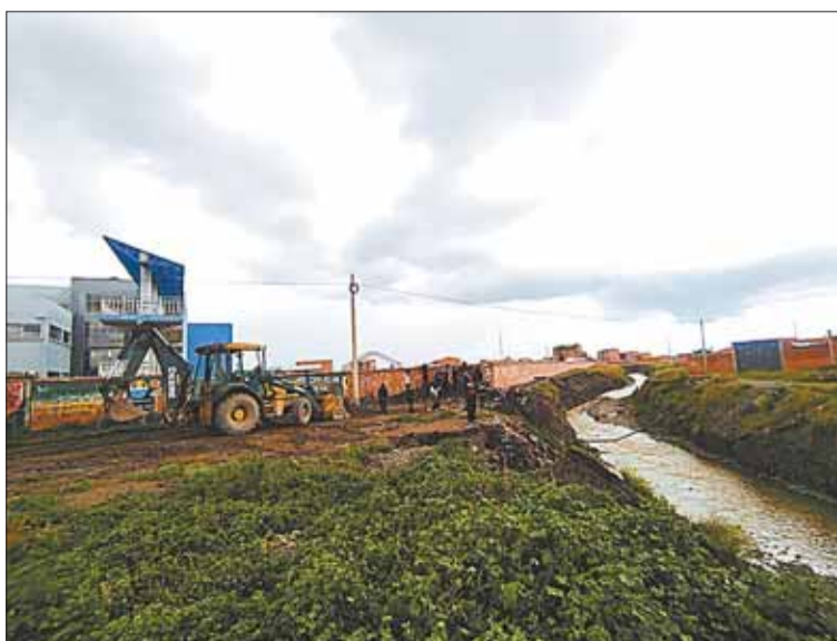
El muro perimetral y otras instalaciones del colegio son afectadas.
