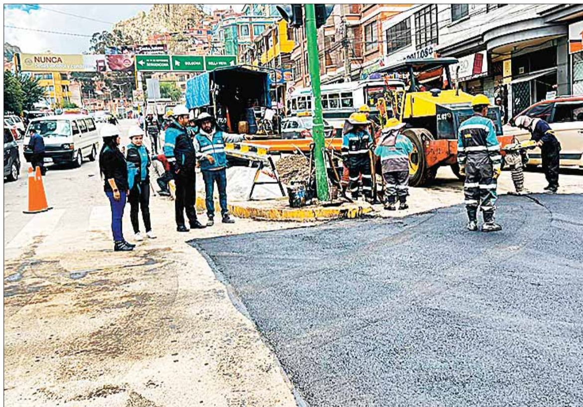
MEDIDA. La reposición del asfalto se pudo concluir y con ello el paso vehicular ya es normal.
