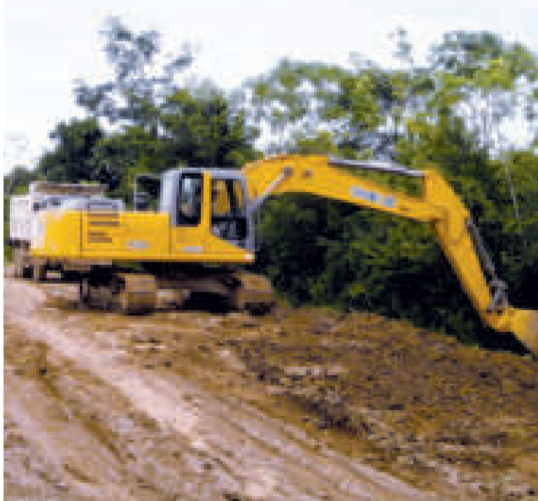
ABC despliega maquinaria para la habilitación de la vía.
