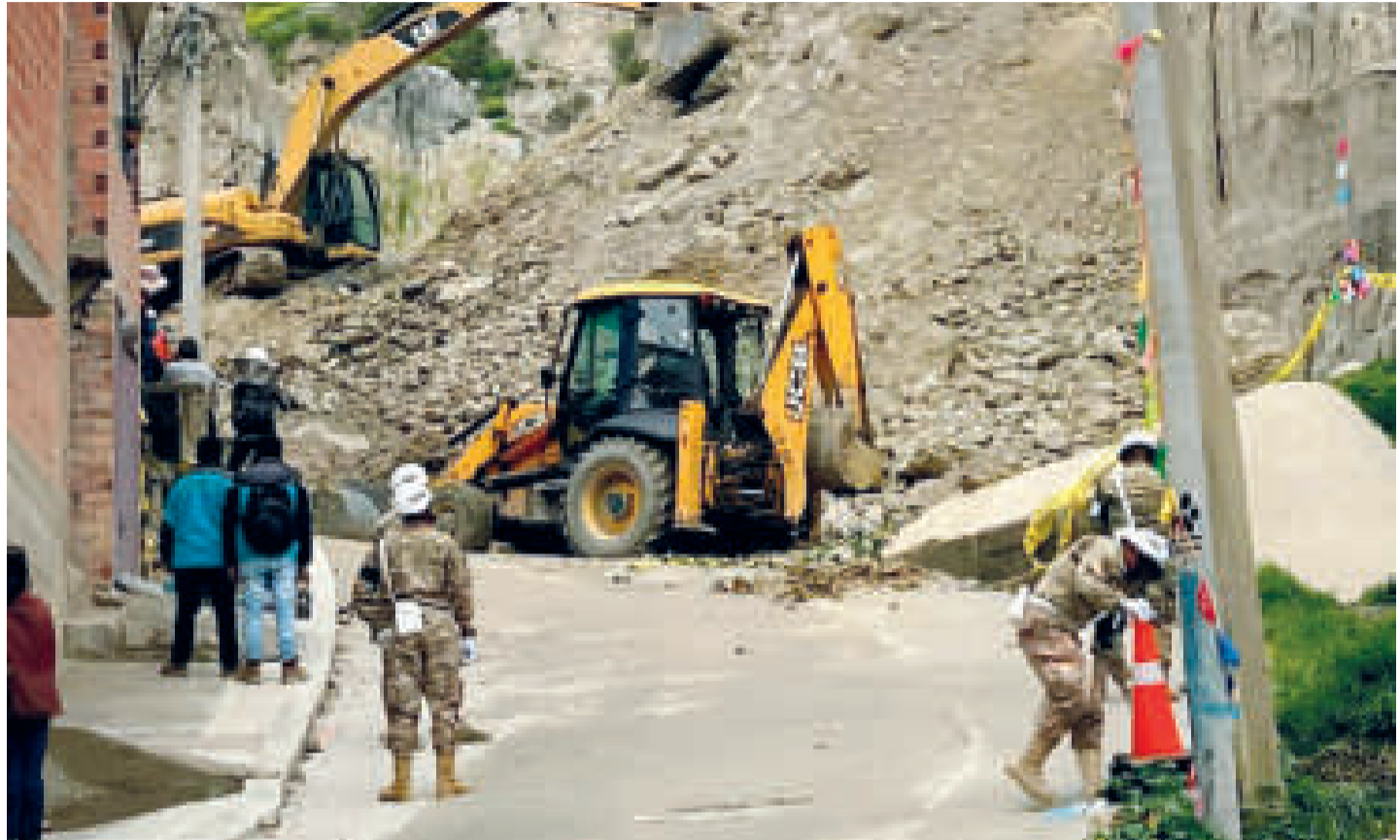
Trabajos de remoción de tierra en la zona Jinchupalla, con el apoyo del grupo de rescate SAR FAB Illimani.
