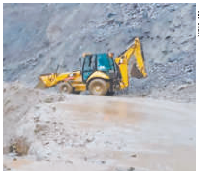
La maquinaria despeja con celeridad las vías obstruidas por las lluvias.
