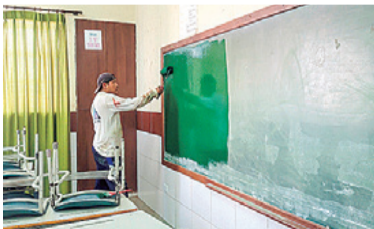
Los trabajos que se realizan en el interior de las aulas
