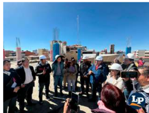
En inspección, se verificó la situación actual de la obra / LA PATRIA
