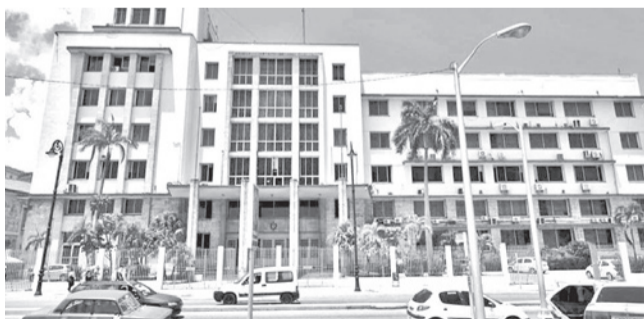
Edificio del conglomerado comercial Gaesa, en La Habana, Cuba. FRANCE 24
