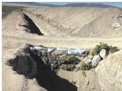
El puente clandestino construido para salvar la zanja en la frontera.
