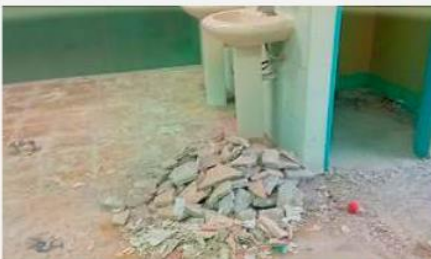
Refaccionan consultorios en el Cimfa 10 de Febrero / CNS ORURO
