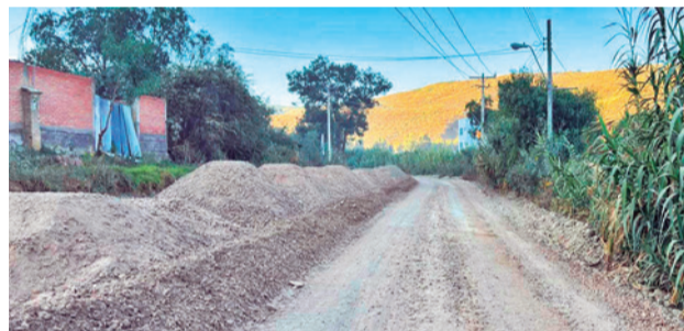
La obra de asfaltado en el extremo sur de Quillacollo.
