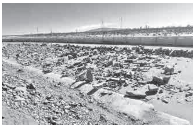
El mal estado de la vía por los bloqueos. ABI
