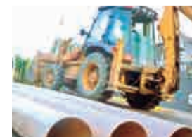
Trabajos en la Av. Blanco Galindo. SEMAPA
