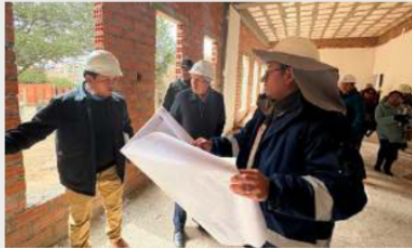
Hospital de Especialidades de Alta Complejidad seguirá en construcción /LA PATRIA
