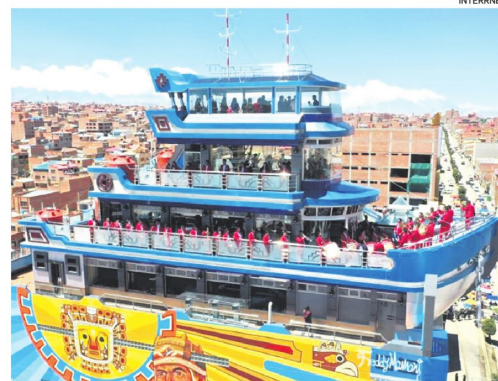
Un barco anclado encima de un edificio. Es un chólet de El Alto.
