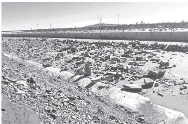
Tramo de la carretera fundamental Oruro-Cochabamba. ABC
