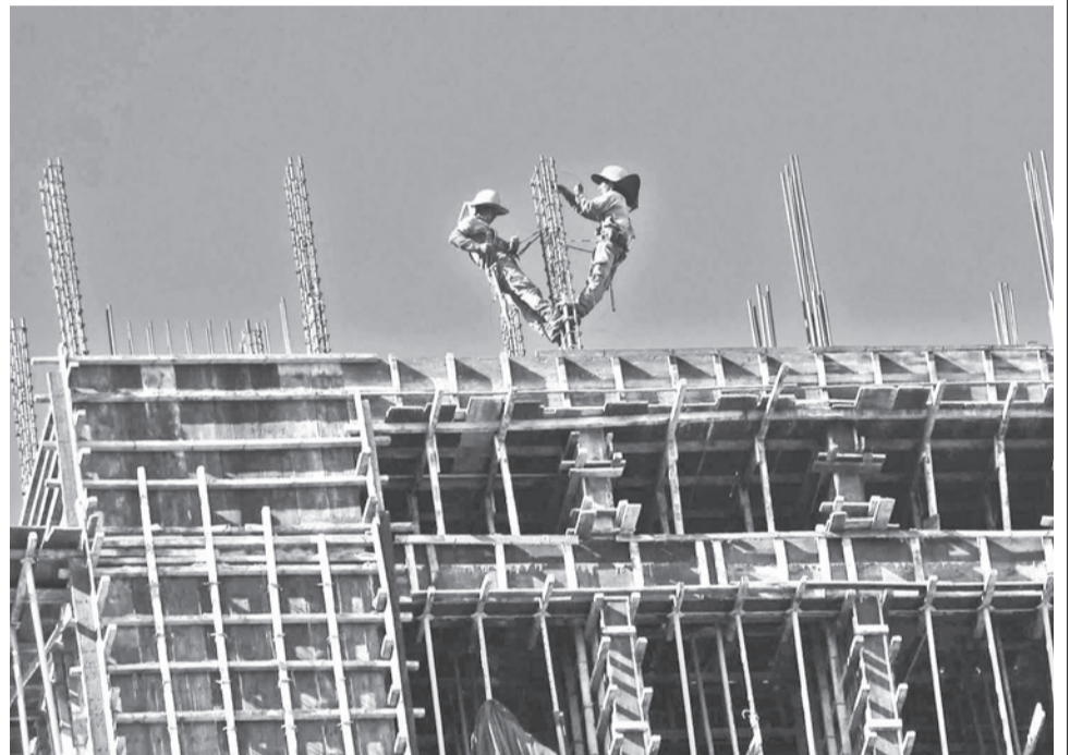
Trabajadores en una edificación en altura. CARLOS LÓPEZ
