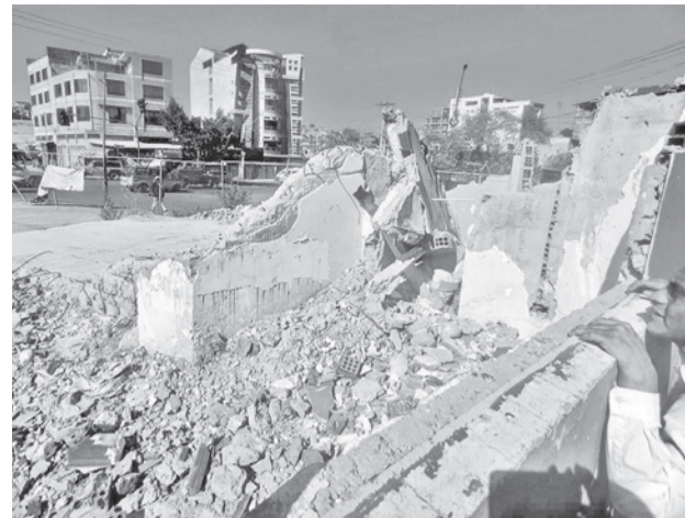
El lugar abandonado tras la demolición.
