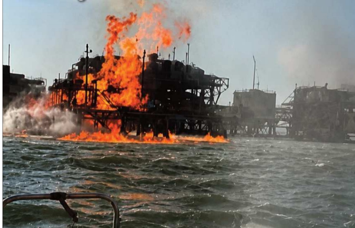
INCENDIO La explosión destruyó parte de la planta compresora de gas de PDVSA.
