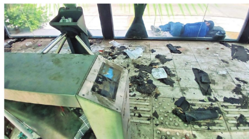
Esta infraestructura también se la utiliza como urinario.
