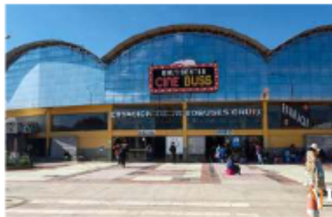
Fachada de la Estación de Autobuses Oruro /EAI
