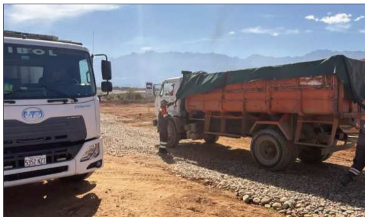
TRABAJO. Camiones depositan residuos en un predio en Cotapachi
