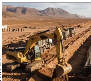
Construcción de una zanja.
