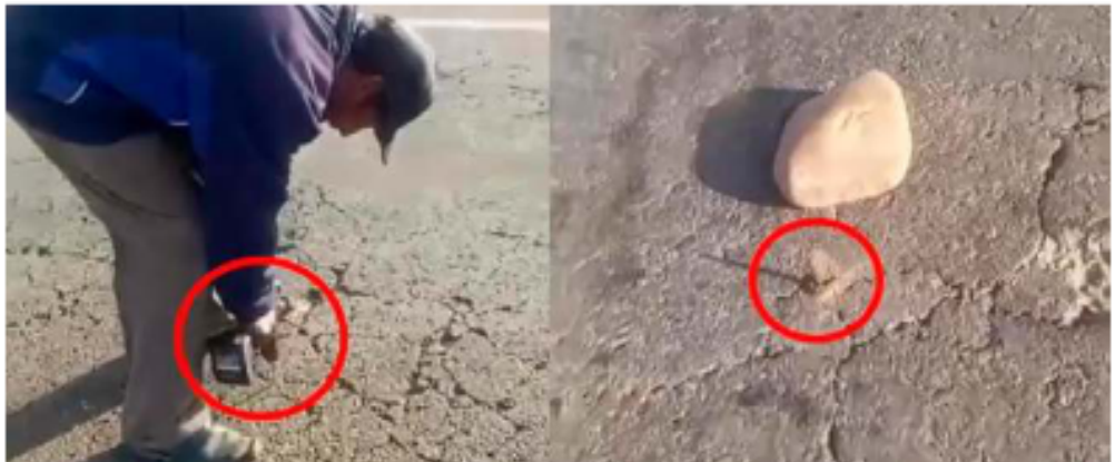
Una persona utiliza un taladro industrial para perforar la capa asfáltica /CAPTURA DE VIDEO
