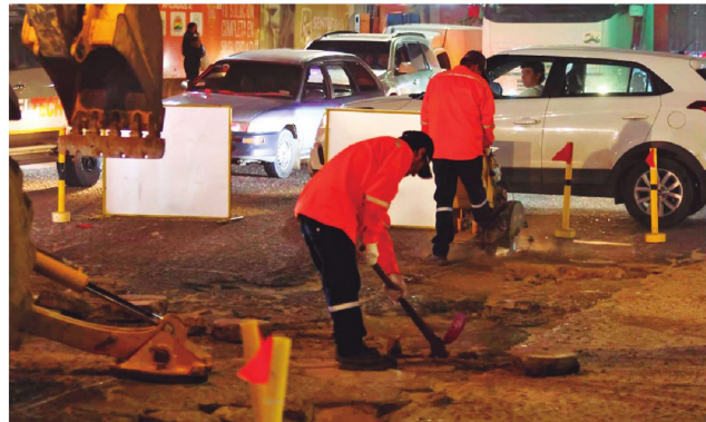
Se ha reforzado el trabajo nocturno para no afectar el tráfico vehicular
