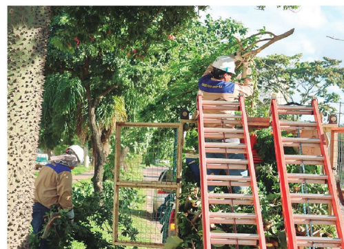
Los trabajos en el camellón del cuarto anillo y avenida San Martín
