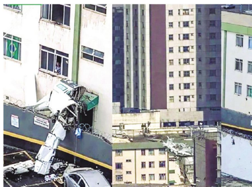
La aeronave se incrustó en la caja de escalera de este edificio
