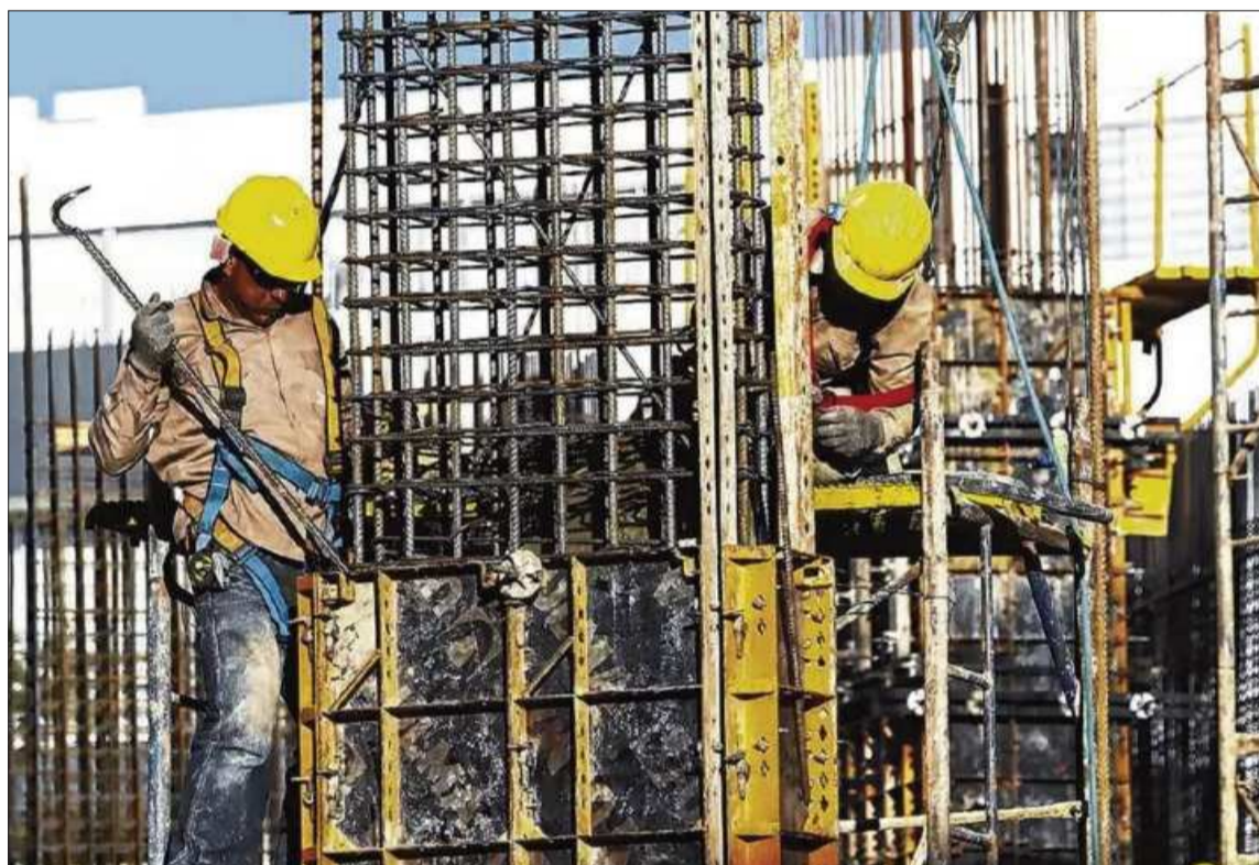
ARMADO. Dos albañiles trabajan en una obra de construcción en la ciudad de La Paz.
