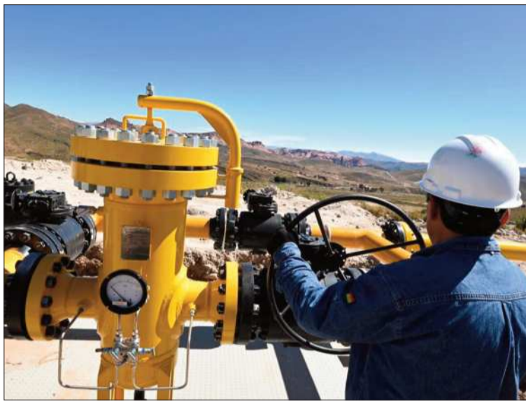
MANTENIMIENTO. Un trabajador de YPFB, en un ducto de gas.
