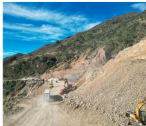
Se levantan las restricciones el 1 de mayo tras concluir las obras / ABC
