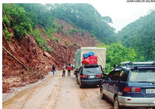
Lluvias persistentes afectan las carreteras del país.
