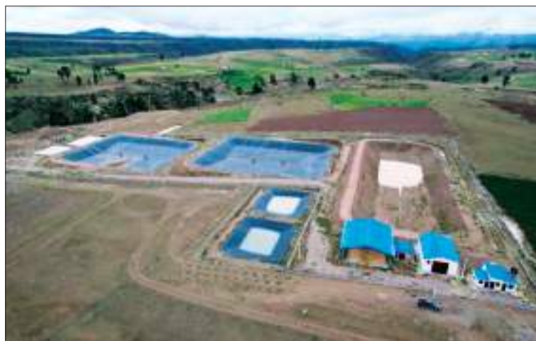
RELLENOS. Solo 12% de municipios del país cuenta con rellenos sanitarios.
